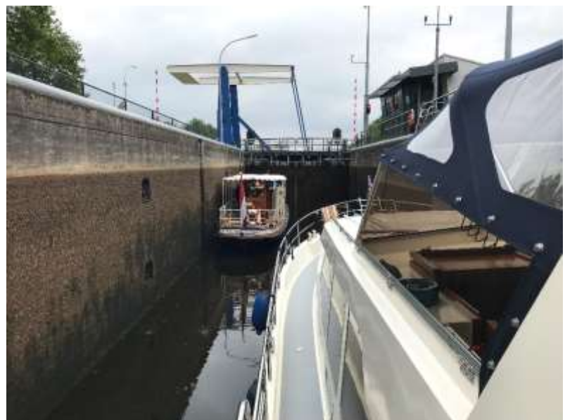
Volle Konzentration beim Schleusenfahren
